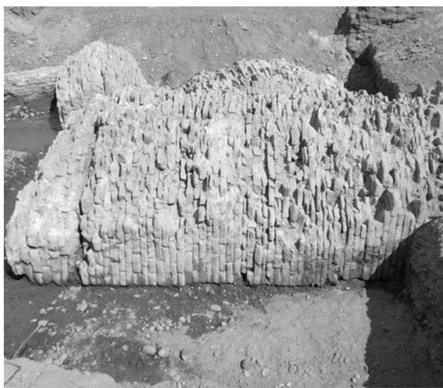
Fig. 24. Acqui Terme. Acquedotto romano di *Aquae Statiellae*. Dettaglio del pilone A con visibile l'attività di spoglio nella parte superficiale (foto Lo Studio s.r.l.).
