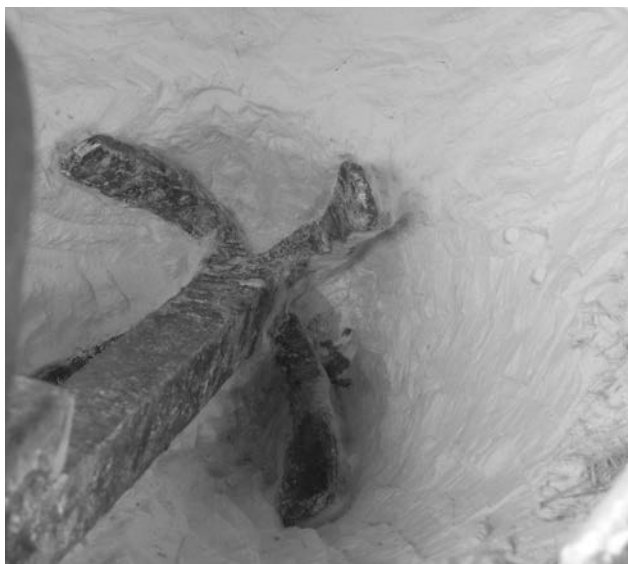
Fig. 26. Perno in ferro liberato dal riempimento (foto M. Magnasco).
